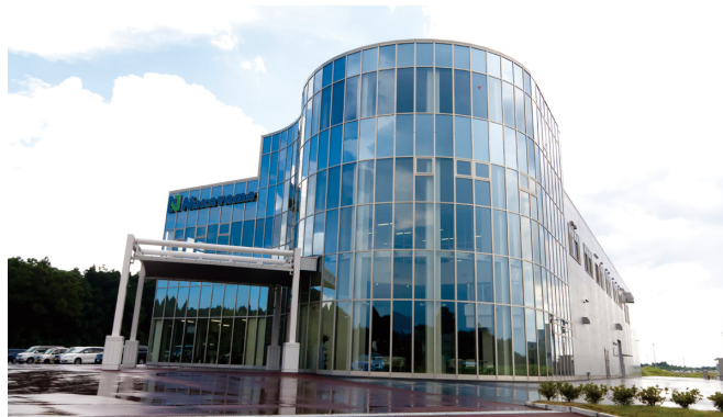
2013年2月にオープンしたナカヤマ精密(株)のテクニカルセンター。太陽光発電設備をはじめとするエコ機器や、最新のハイテク加工設備を導入している
