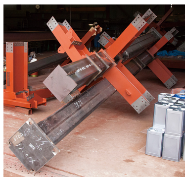
組立中の鉄骨
